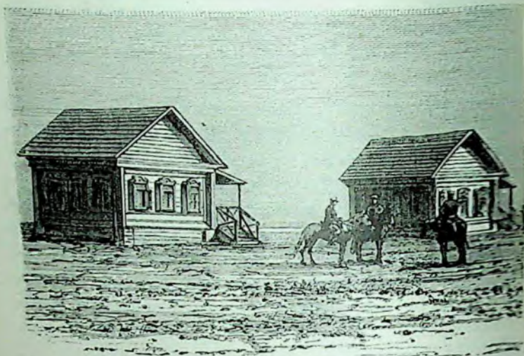
Maisons des employés du chemin de fer.
